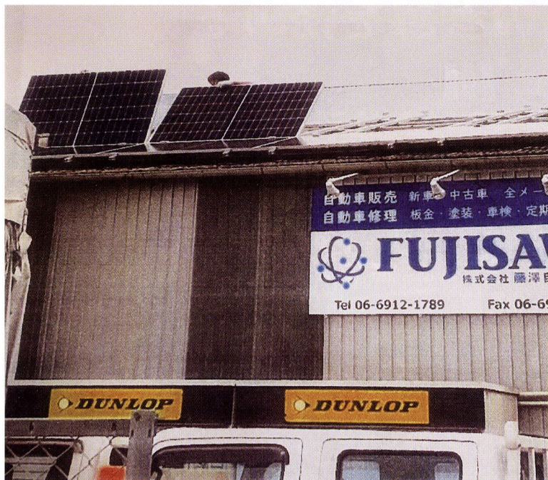
▲藤澤自動車工業所のパネル設置工事の様相
