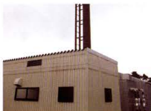
▲廃棄タイヤを燃料にする大型のボイラー設備
